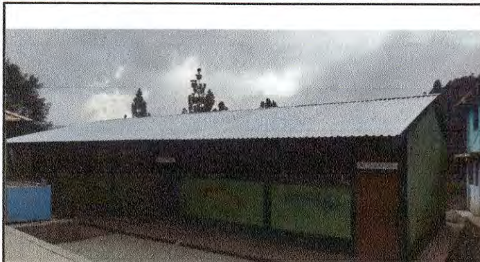
Foto1: Sustitucion de lamina, por lamina troquelada zinc calibre 26, aula 1, 2 y direccion con 180 m2
