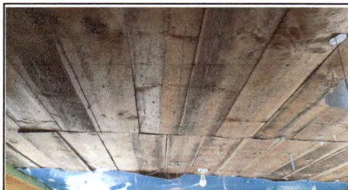
Foto 10: Sustitución de madera.
