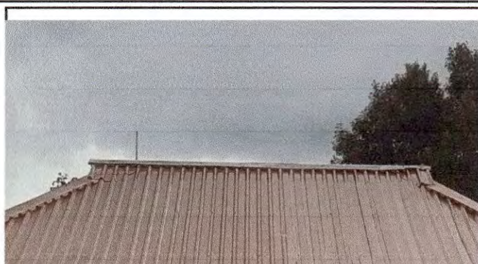
Foto 8: Sustitución de capote para lamina troquelada
