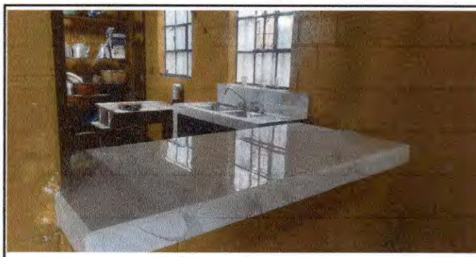
Foto 4: instalacion de lavatrastos e instalacion de deposito de agua de 1000 lt.
