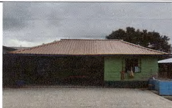
Foto 2: Sustitucion de lamina, por lamina troquelada zinc calibre 26, aula 1 con 63 m2
