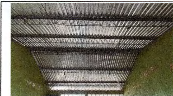
Foto 5: Sustitucioin de estructura de metal para lamina troquelada.
