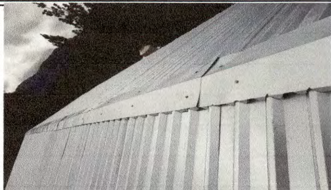
Foto 7: Sustitución de capote para lamina troquelada.
