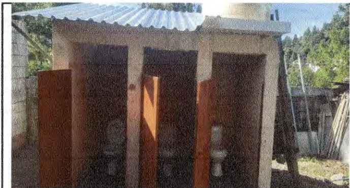
Foto 3: sustitucion de inodoros por tazas lavables baños 1, 2 y 3 e instalacion de deposito de agua de 1000 lt
