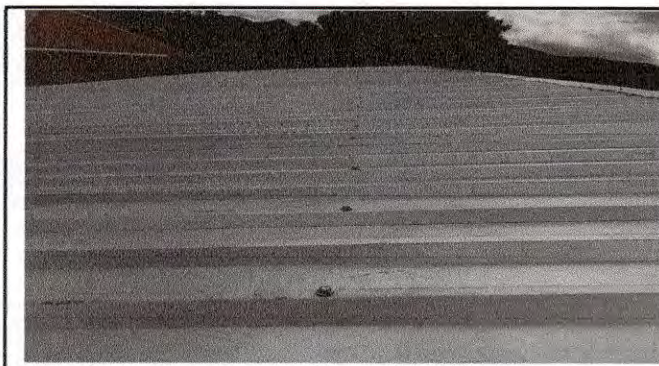
Foto 6: Sustitucion de elementos de fijacion para lamina troquelada.
