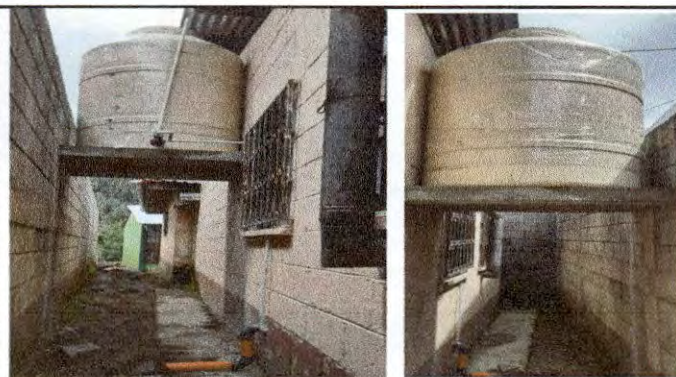
Foto 9: Instalación de tinacos para depósito de agua exclusivo para cocina.
